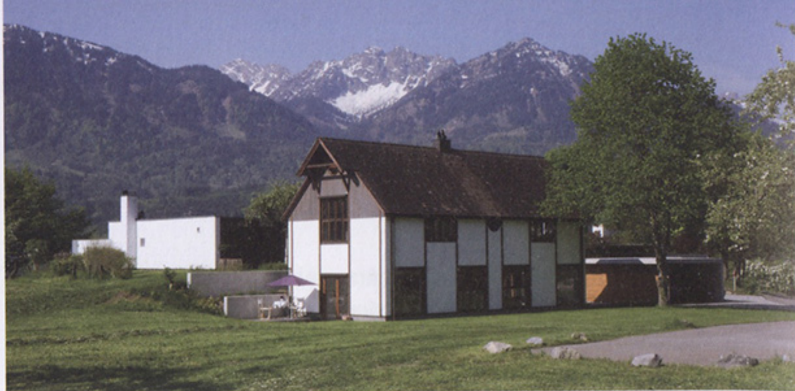
(236) Atelier Gassner in Schlins, Vorarlberg. Architektur: Rudolf Wäger, 1975 Atelierzubau von 1986. Foto: Bruno Klomfar
